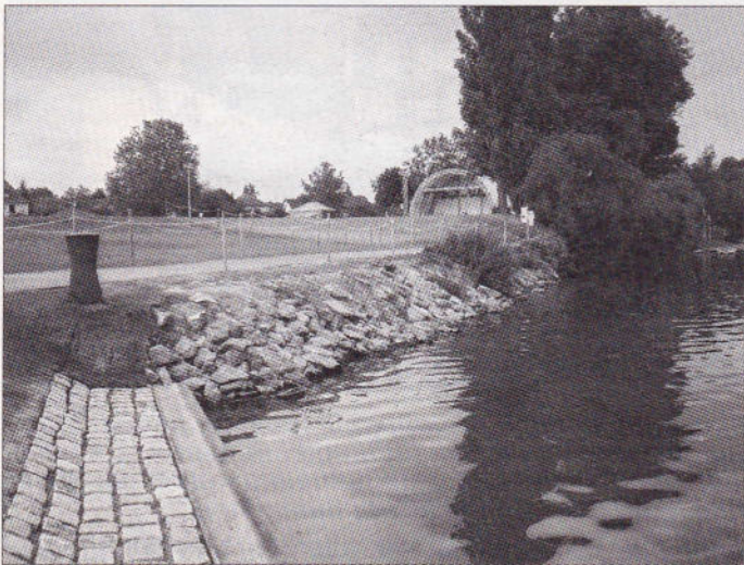
Blick von der neu angelegten Schiffsanlegestelle: Neckarufenerweg nah am Wasser und höher gelegene Liege- und Festwiese, auf der auch Open-Air-Konzerte stattfinden
